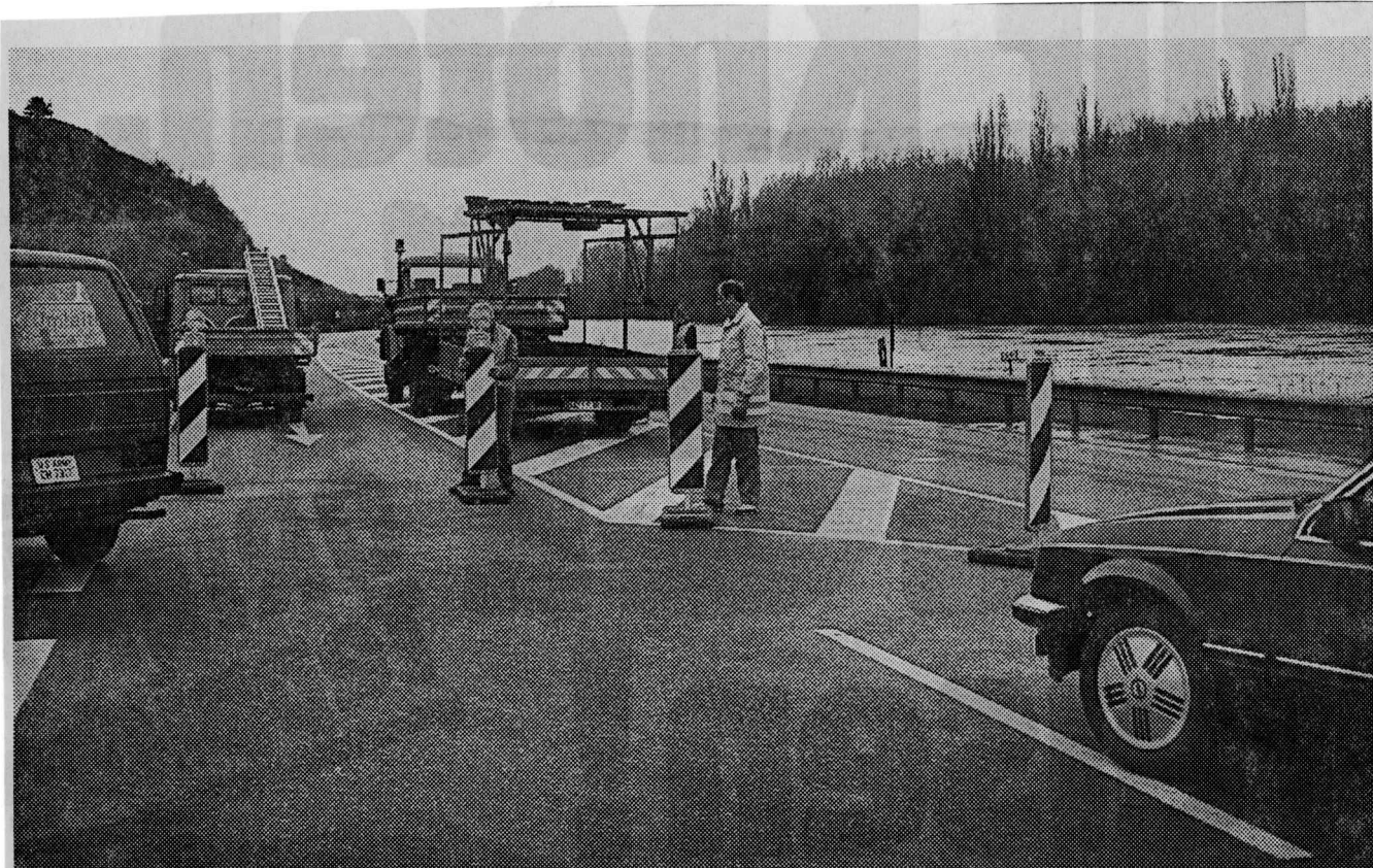
Gestern morgen wurden die Sperrschilde auf der Bundesstraße 9 bei Nackenheim aufgestellt. Das Rheinhochwasser hatte schon die Höhe der Straßendecke erreicht. Bild: Baum
